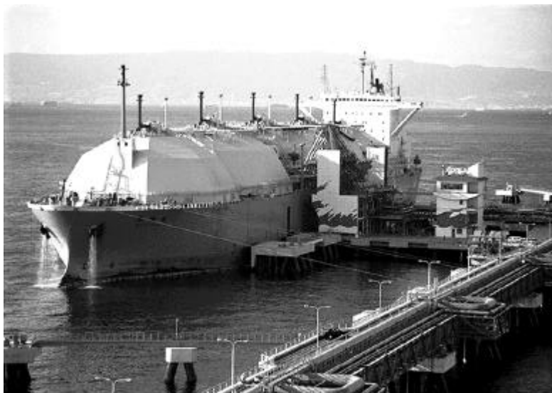
LNG Unloading at Berth No. 2
